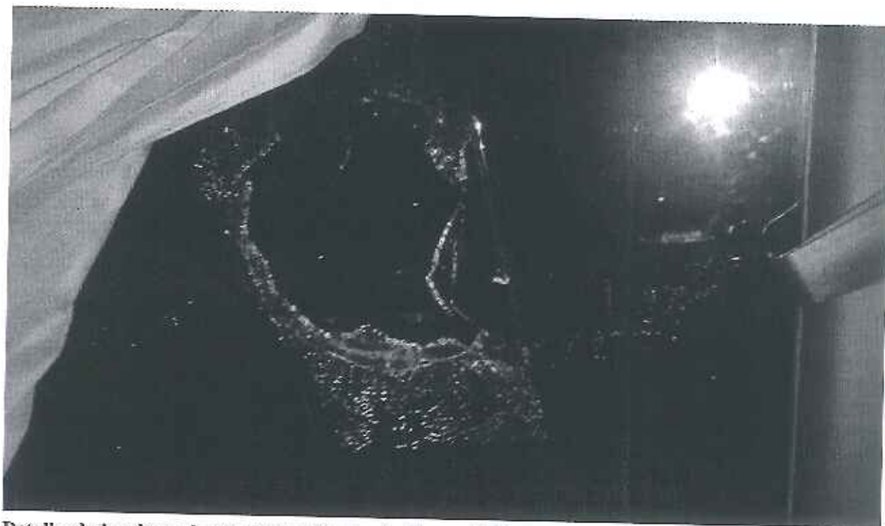
Detalhe da janela quebrada (Foto: Divulgação/Ferroviário)
